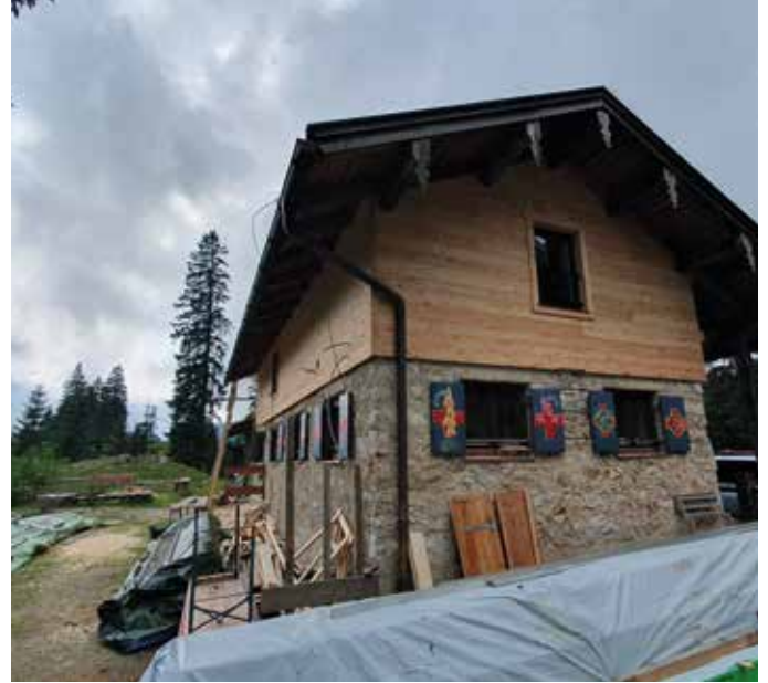
■ Es geht voran: aktueller Sanierungsstand
